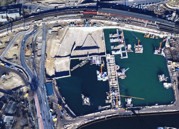
Nádrž na vodu pred neutralizáciou kyselinou uhličitou.
