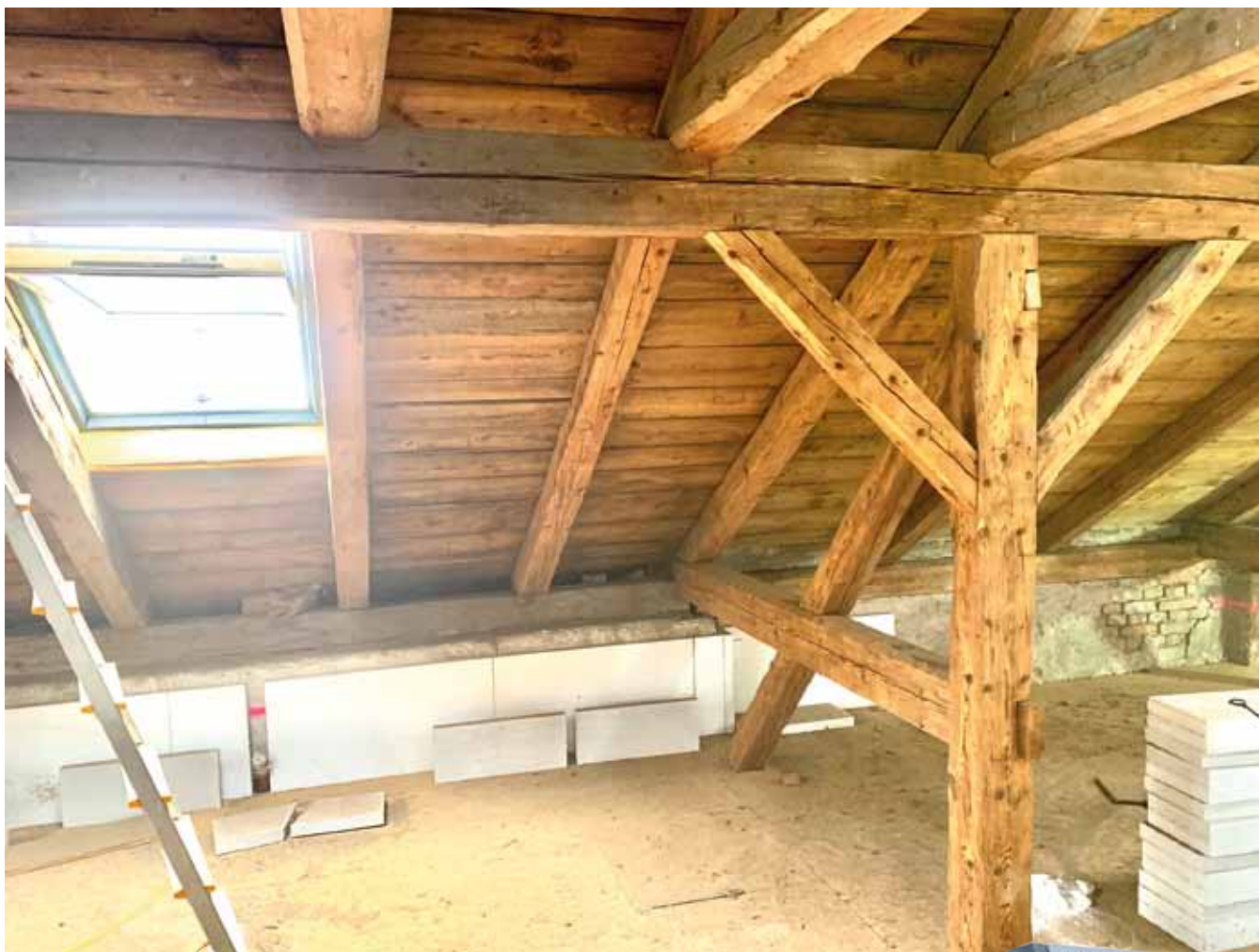
Půdní prostor s dřevěnými prvky očištěnými pomocí metody tryskání suchého ledu
