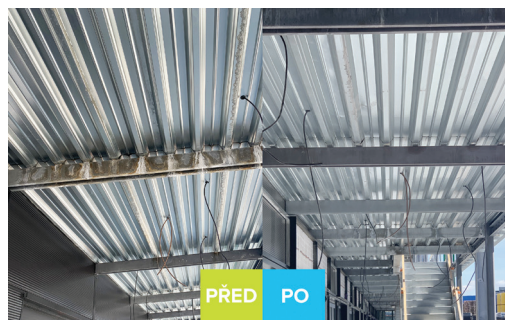
Obr. 3 – Plechová střecha, před a po aplikaci
