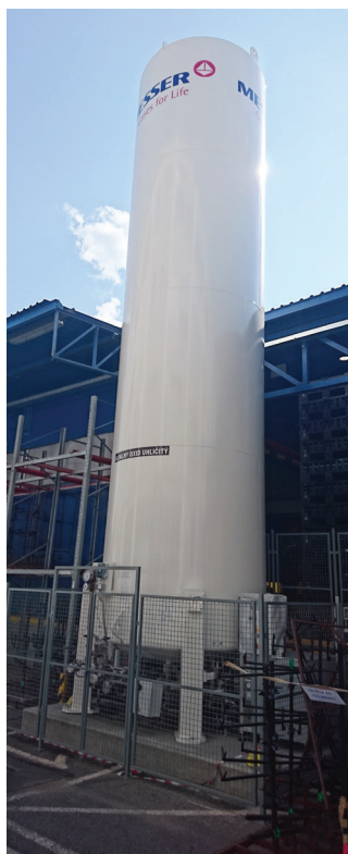
Obr. 1 – Kryogenní zásobník pro skladování kapalného oxidu uhličitého
