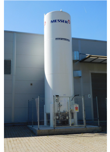
Obr. 2: Kryogenní zásobník pro skladování kapalného oxidu uhličitého
