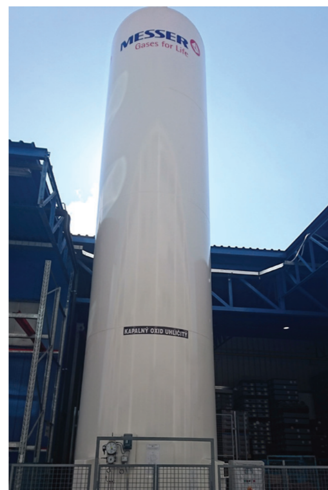
Obr. 3 - Kryogenní zásobník pro skladování kapalného oxidu uhličitého
