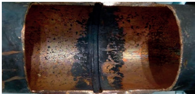
Obr. 3a – Spoj měděné trubky bez použití formovacího plynu
