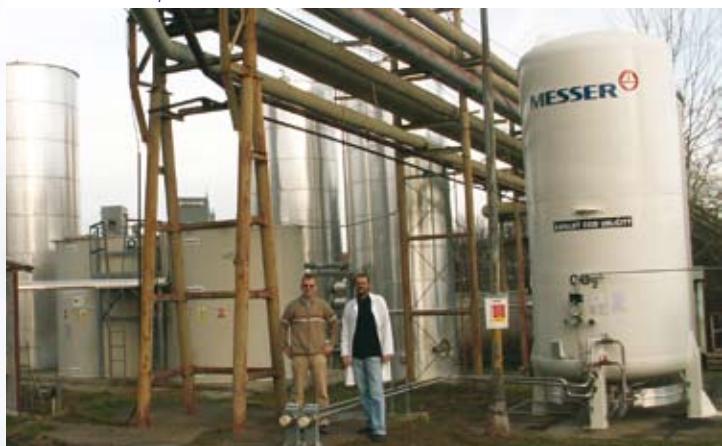
Obr.: Přestavba neutralizace z minerální kyseliny na CO_2 mlékárenského provozu
