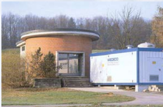
Obr.: Systém ozón/UV pro oxidaci chlorovaných uhlovodíků v pitné vodě.
