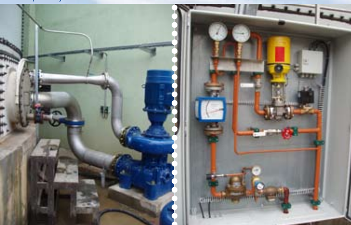
Obr.: Vnos kyslíku do výtaku kalového čerpadla je umístěn vně nádrže
