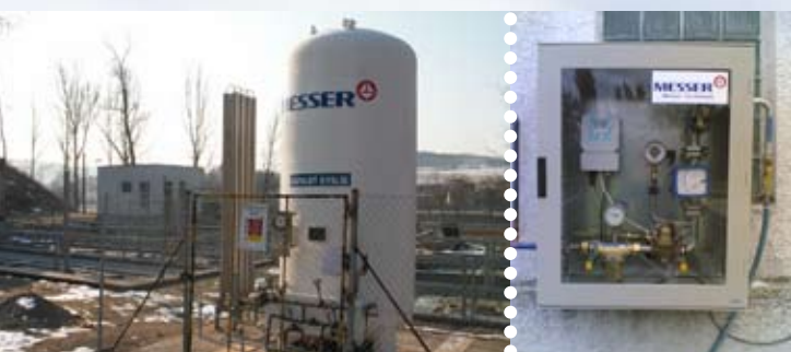
Obr.: Kyslíková aktivace malé ČOV
