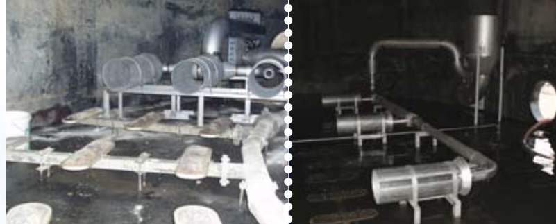
Obr.: Trysky injektorů uvnitř aktivace nad původními aeračními elementy
