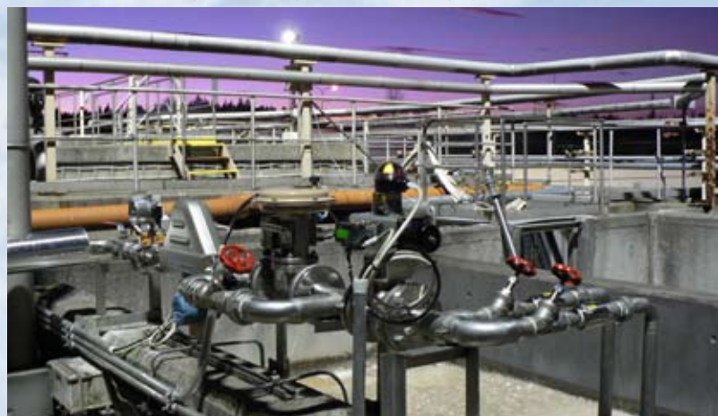
Obr.: Automatická regulační řada pro vnos až 600 kg kyslíku za hodinu.
