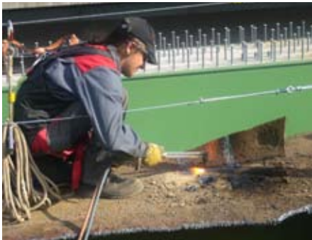
Die Sauerstoffflanze „knackt“ auch massive Stahlbleche.
