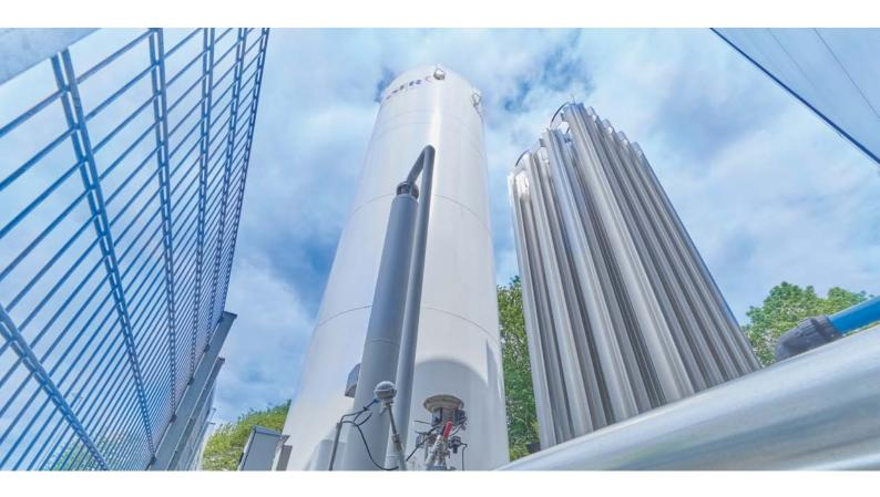
Mit der Kälte verflüssigter Gase aus dem Eco-Vap-Verdampfer arbeiten Kühlsysteme umweltfreundlich und effizient. Viele Produktionsbetriebe nutzen Industriegase wie Stickstoff, Sauerstoff, Kohlendioxid oder Argon, die in tiefkalter, verflüssigter Form gelagert werden.
