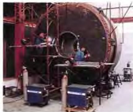
Mit 50000 Rundschweißungen fertigte das Unternehmen für Anlagenbau, Mabet, in Italien Kühlaggregate für ein Chemiewerk in Rußland
