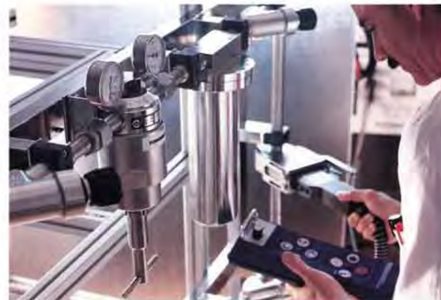
Selbst im Reinraum können Rohrleitungsteile für Reinstgasversorgungsanlagen geschweißt werden, geschützt in einer Zange der Tochtergesellschaft Polysoude
