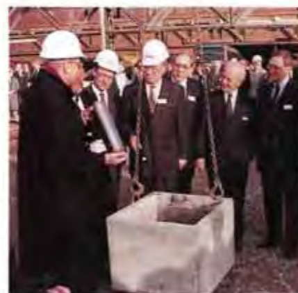
Grundsteinlegung der Luftzerlegungsanlage in Duisburg, u. a. zu Gast: Minister Günther Ebert (l. v. r.) u. Bürgermeister Friedel Genender (r. v. r.)
