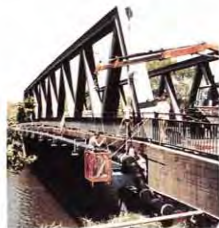
Keine Verkehrs- und Umweltbelastung – ein Vorteil von Rohrleitungen für den Gasetransfer; die neue Trasse überquert den Rhein-Herne-Kanal
