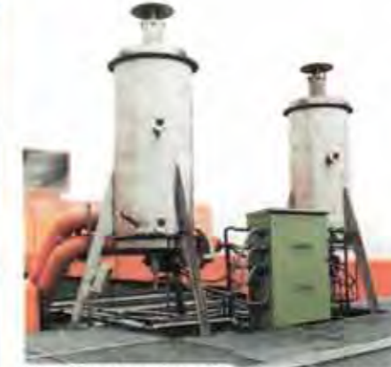
Vom Gesetzgeber gefordert – von der Klinik erfüllt: eine Brennanlage zum Entsorgen von Ethylenoxid
