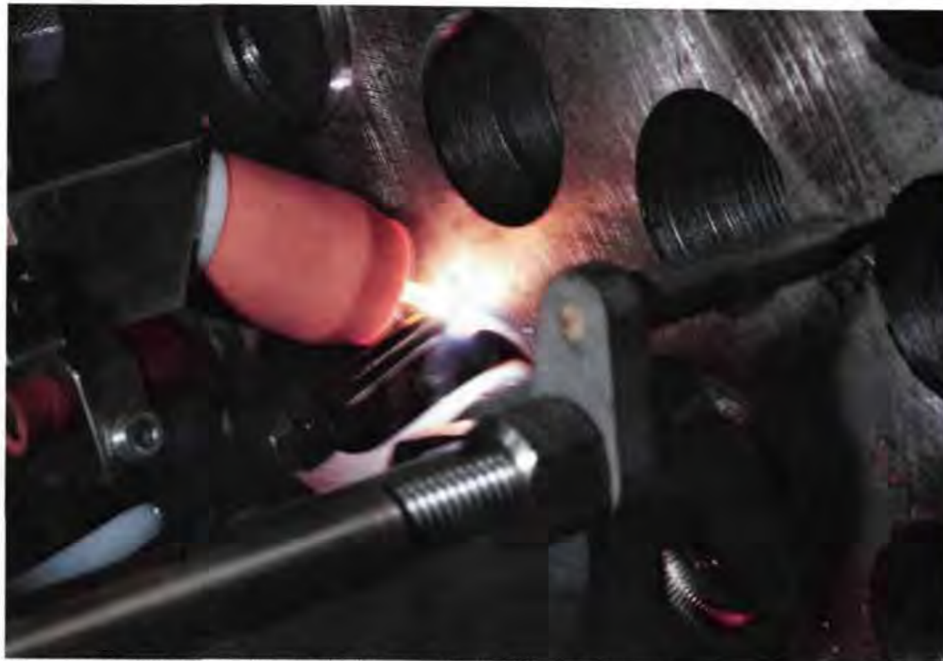
Polysoude ist Spezialist für das Rohr-Bodenschweißen, zum Beispiel an Wärmetauschern, und ...
