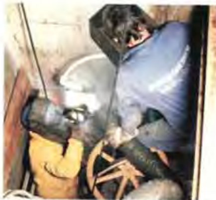
... dem Stausee konnte der defekte Schieber ausgetauscht werden.
