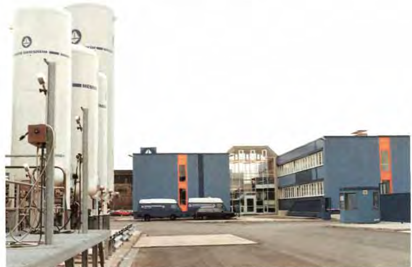
Zukunftsweisend: das neue Industriegase-Werk in Oberhausen mit High-tech-Zentrum für Schweiß- und Schneidtechnik
