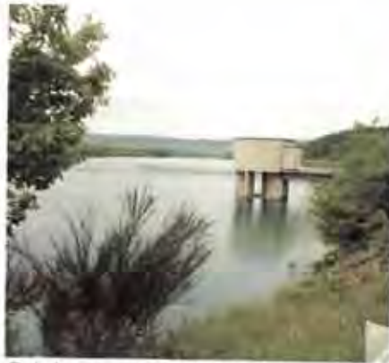
Rohrfrosten verhindert das Entleeren eines Stausees: Nach der Bildung eines Eispfropfens in einer Rohrleitung unter ...
