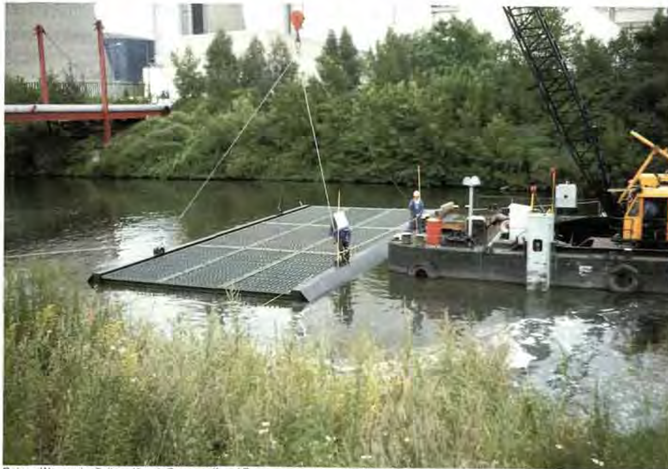
Reines Wasser im Teltow-Kanal: Sauerstoff und Begasungsmatten verwirklichen Berliner Umweltschutz-Projekt.
